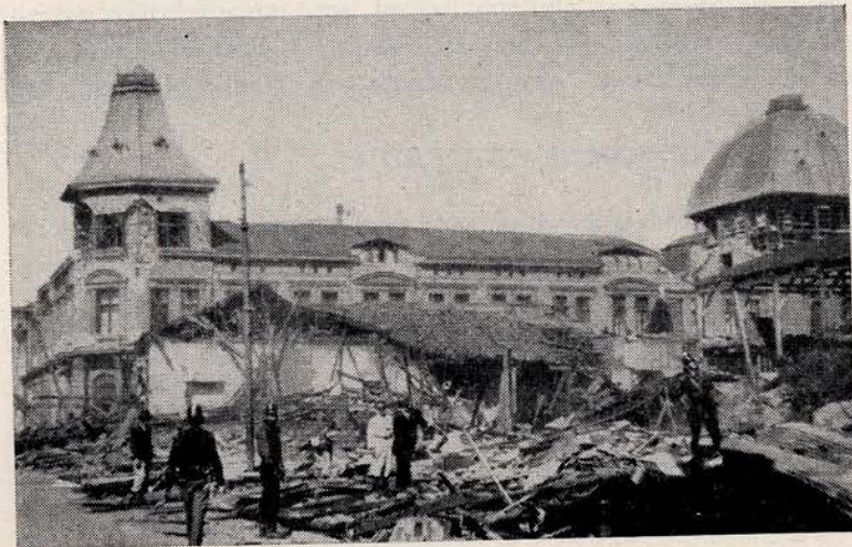
Terremoto de Chillán. Vista parcial
