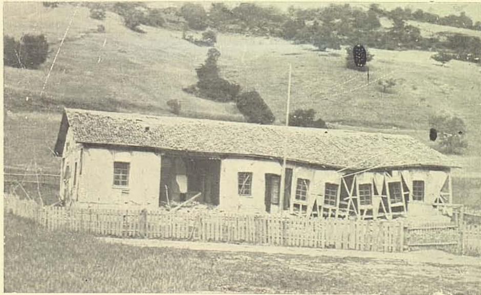
Res. 4 Abant yolu üzerindeki Akçaalan köyü ilkokulunun cepheden görünüşü
