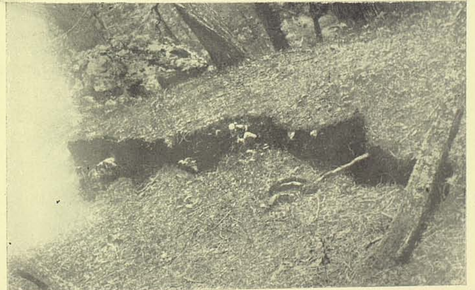
Res. 6 Abant yolu üzerinde 20 ci km. deki toprak açılması
