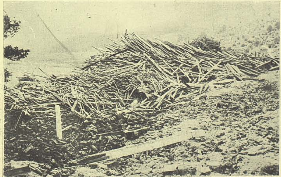
Res 9 Abant'daki eski otelin zelzeleden sonraki hali (enkaz kaldırılmıştır)
