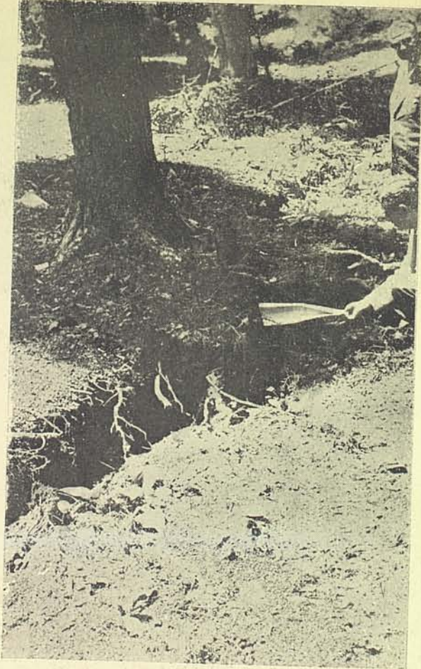
Res. 7 Abant yolu üzerinde 20 ci km, deki toprak açılması
